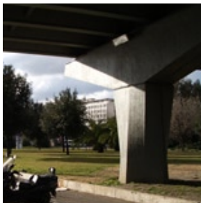
CORSO FRANCIA VIADUCT P.L. NERVI
